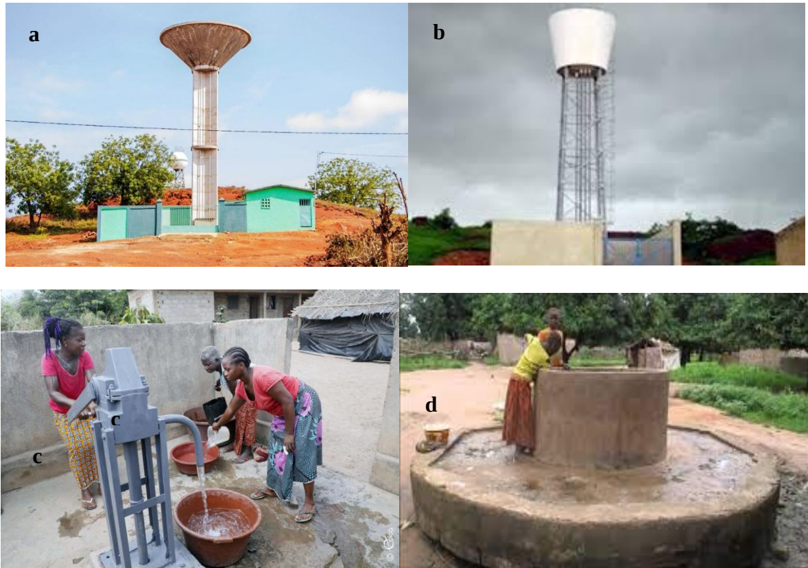
Figure 5 : Ouvrages d'approvisionnement en eau potable (23/02/2021) a : Château à Kokoumbo, b : HVA à Angonda, c : PMH à Blaisekro, d : Puits à Amonkro
