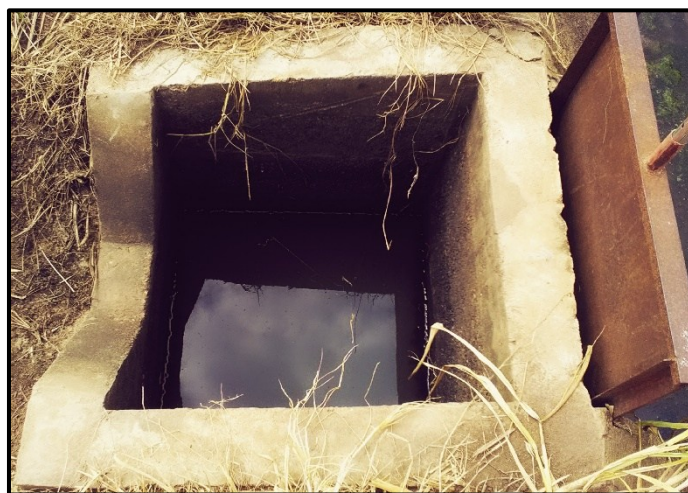
Figure 17 : Ouvrages de chute
