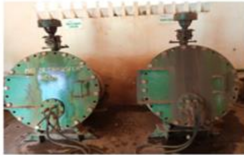
Mât de transfert des conduites d'aspiration
