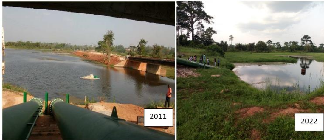
Figure 40 : Etat d'Eutrophisation de la retenue d'eau brute
