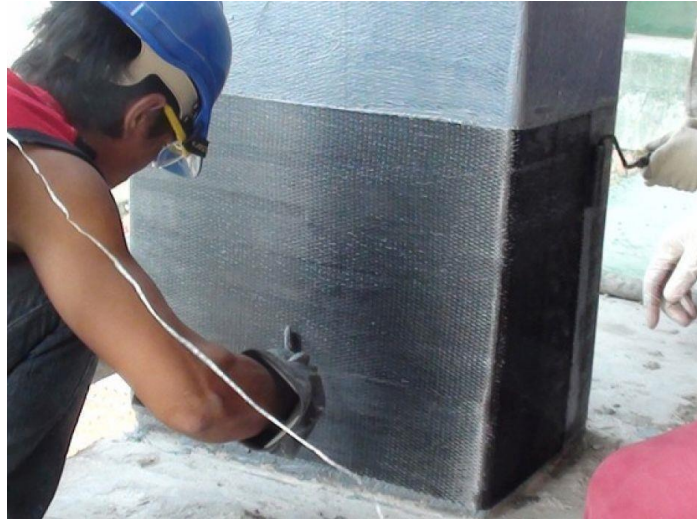
Figure 1.19. Chemisage en fibre d'un poteau.
