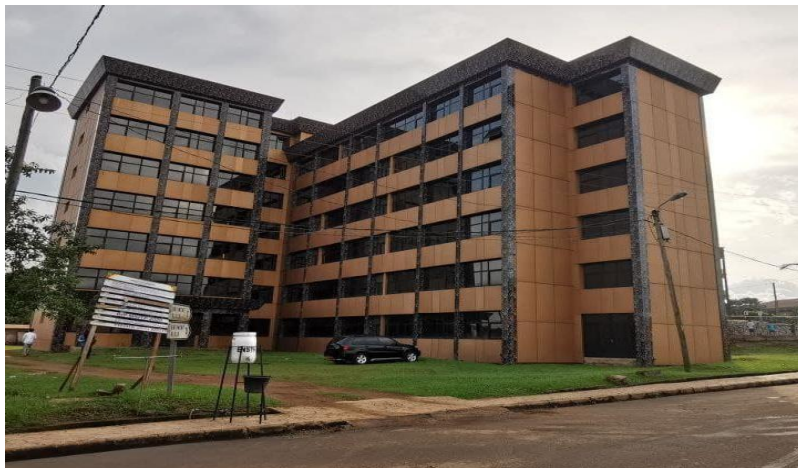
Figure 3.3. Nouveau bâtiment administratif de l'ENSTP
