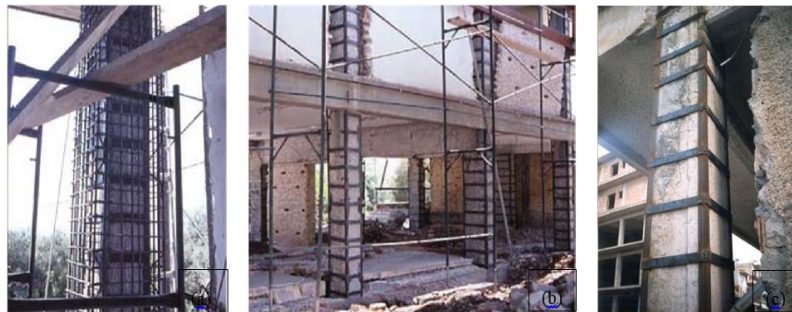
Figure 1.17. Chemisage en acier appliqué aux poteaux.
