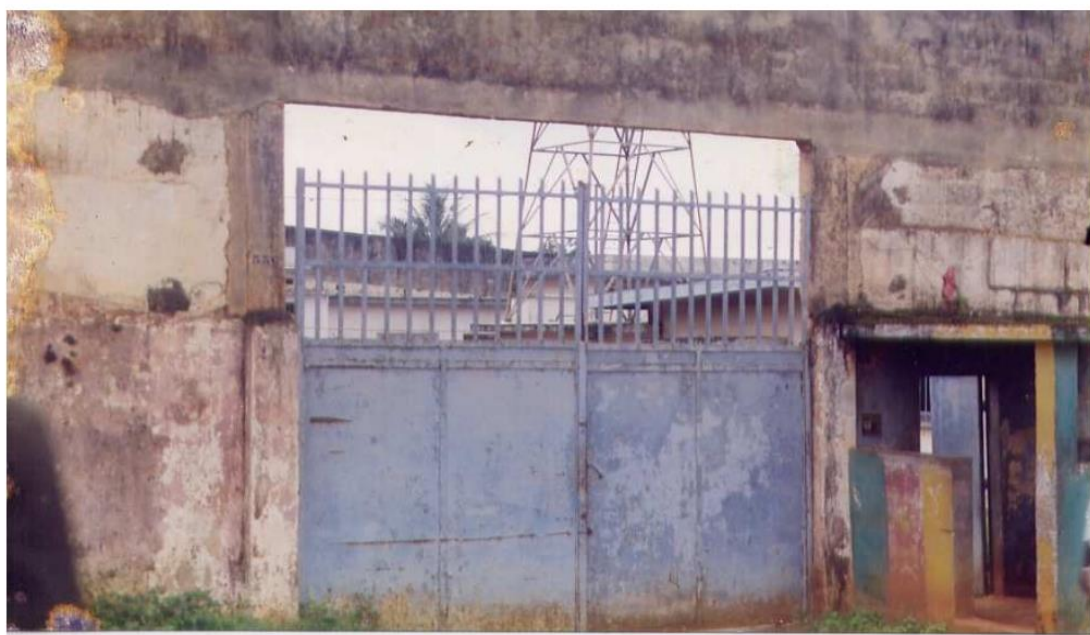
Image 6 : Entrée principale de la BMM de Yaoundé
