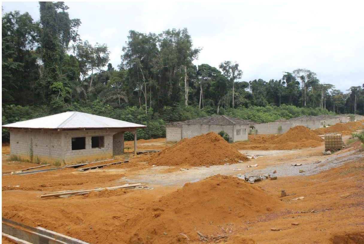
Photo N° 16 : Construction d'une maison moderne
