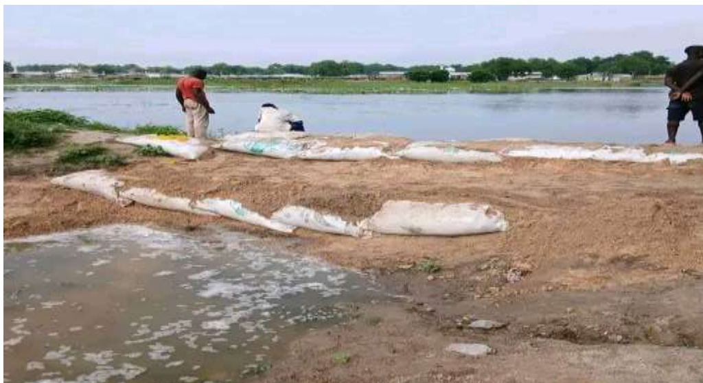
Image 7: Aménagement des routes avec les sacs remplis de sable
