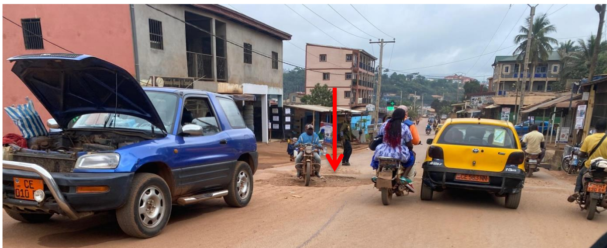
Photo 20: Nid de poule sur les voies de circulation
