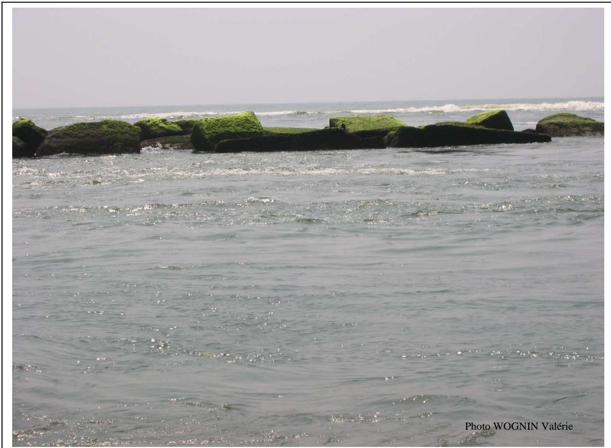
Photo 3 : Epi de protection contre l'érosion isolé par la mer à Grand –Lahou
