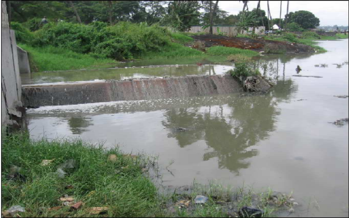
Figure I.5 : Déversement des eaux usées collectées dans la baie de Marcory.
