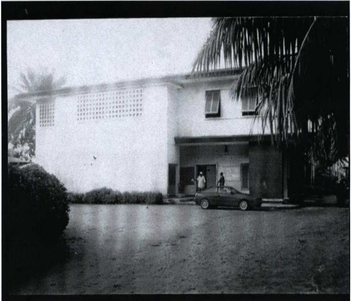
PHOTO 1 : Bloc administratif de l'école régionale de l'agriculture de Bingerville (ex Station agricole de Bingerville).
