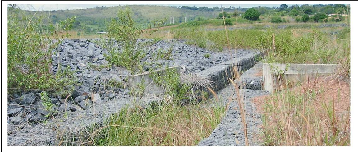
Photo 53 : Système de collecte des eaux de surface sur la mine Mounana (cliché : JPK, 2005)
