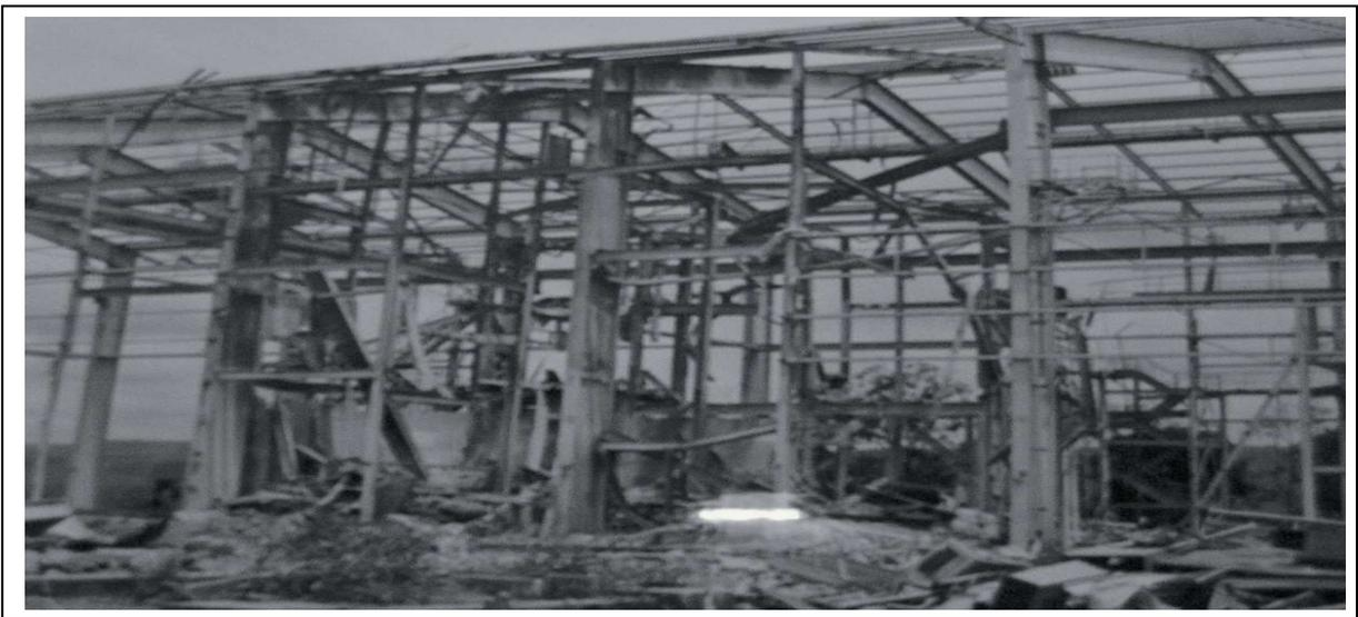
Photo 55 : Démolition de la seconde usine de traitement COMUF (Cliché, COMUF)
