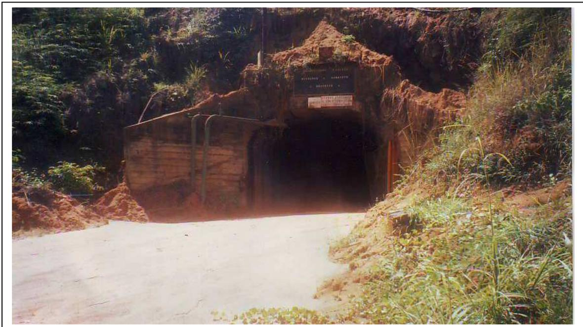
Photo 22: La mine souterraine Oklo, ce type de mine engendre des surcoûts dus aux aménagements supplémentaires (ici la galerie d'accès au fond de la mine) et à l'approfondissement de l'extraction (cliché : J.P.K, 2000).
