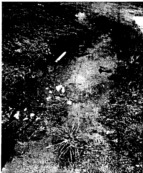
Photo 9 : Egout cassé (gauche), regard comblé (droite) et remontée d'eaux usées sur la chaussée à Biyem Assi
