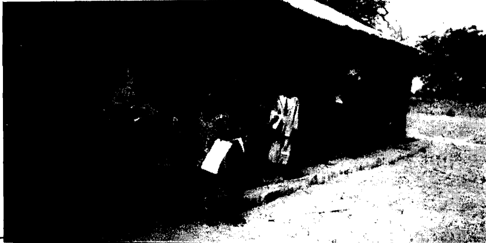
Photo2 : Une salle de classe à l'école primaire publique de Tabota (Boukoumbé). Des ouvertures jouent le rôle de porte d'entrée et de fenêtres. Toiture en tôles et plancher non cimenté
