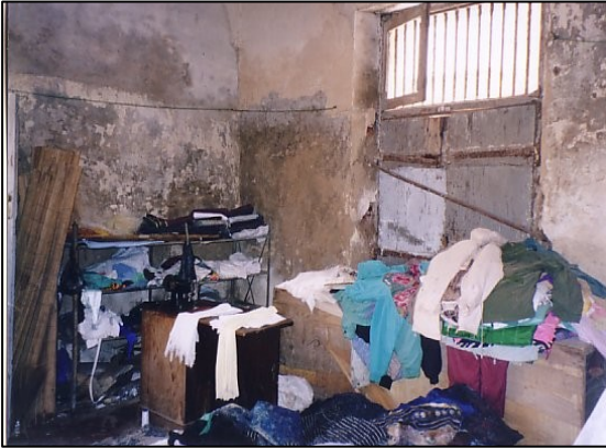
Le local avant réfection
