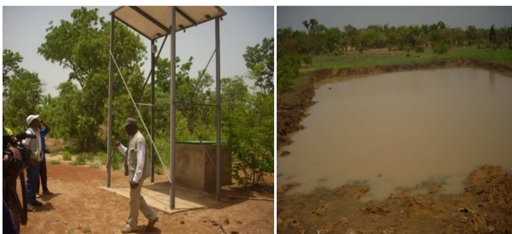
Figure 16: Visite d'un système de forage utilisant l'énergie solaire pour alimenter une mare (Clichés AWESSO, Juin 2012).
