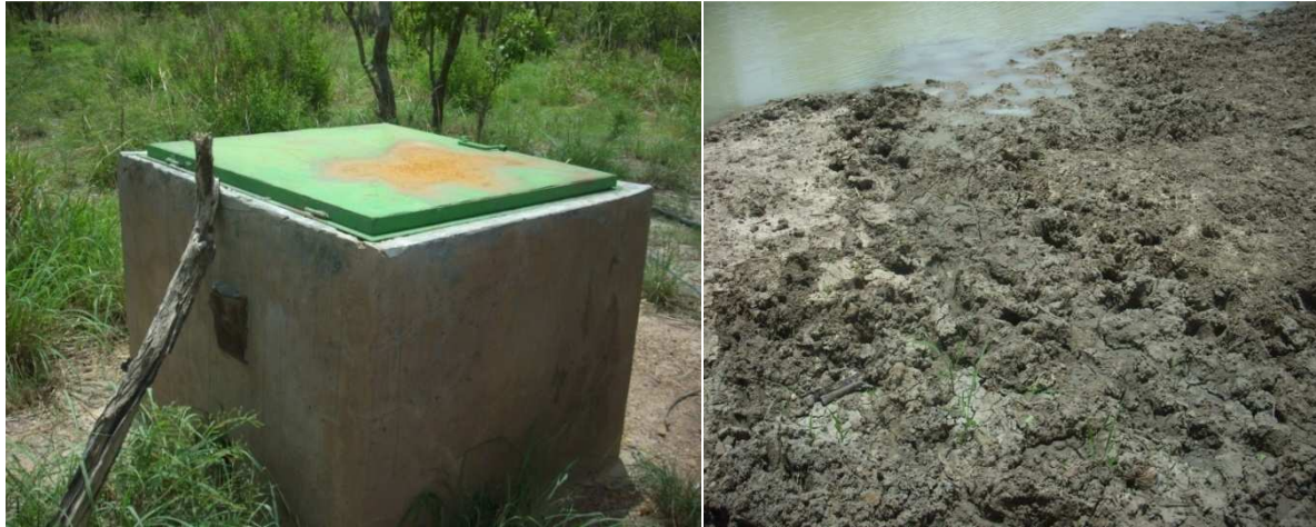
Figure 17: Système de forage utilisant un groupe électrogène pour alimenter une mare (Clichés AWESSO, Juin 2012).
