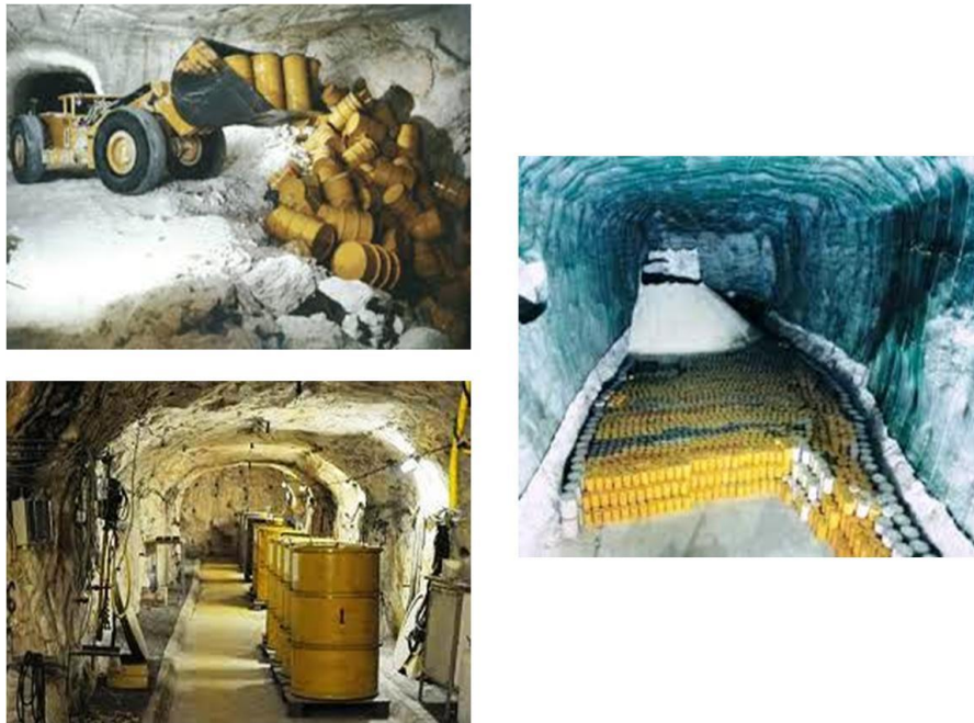
Figure 1.23 : Cavités souterraines de stockage des déchets radioactifs (Manuel de Mécanique de roche, tome1)
