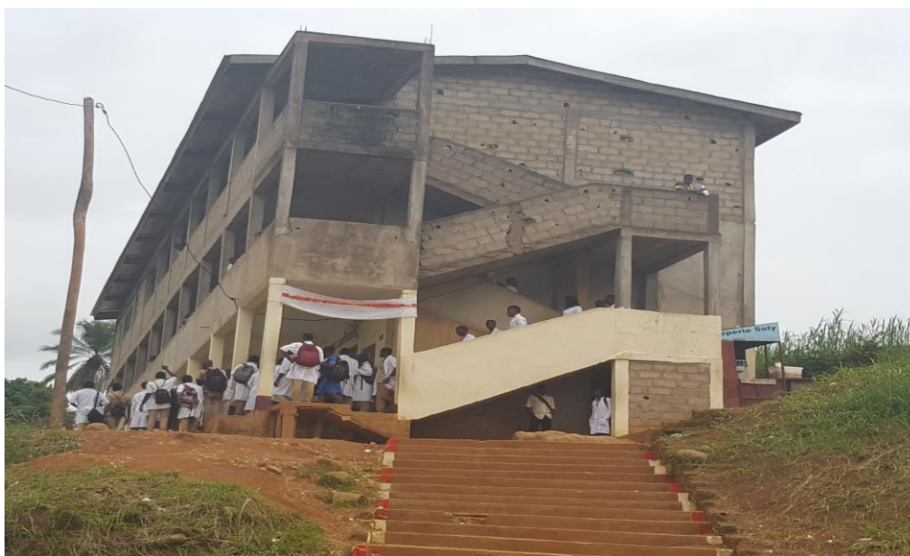
Photo 7: Bâtiment en construction au LBA.
