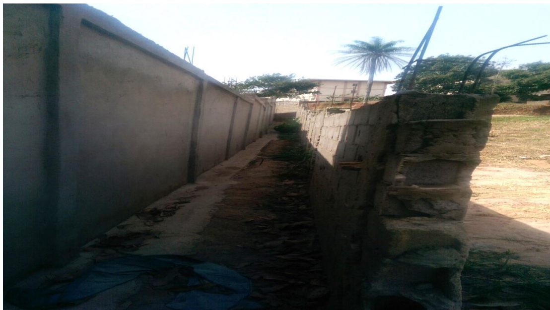
Photo 5 : Clôture de séparation entre l'ENS/LBA
