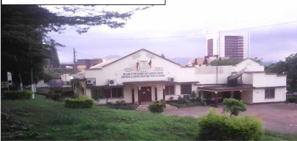
C : Bâtiment du centre linguistique pilote
