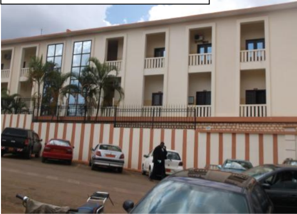
A : Bâtiment de la cours suprême
