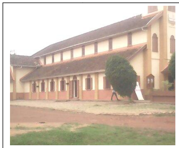
vue de gauche de l'église St Laurent de Mvolyé
