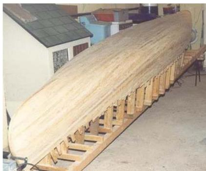
FIGURE 3.3 – Troisième phase : Assemblage du bordé
