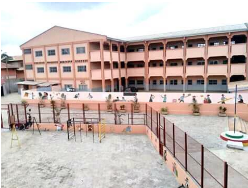
Photo 7: Vue de la façade principale du Collège Mgr Henri Vieter
