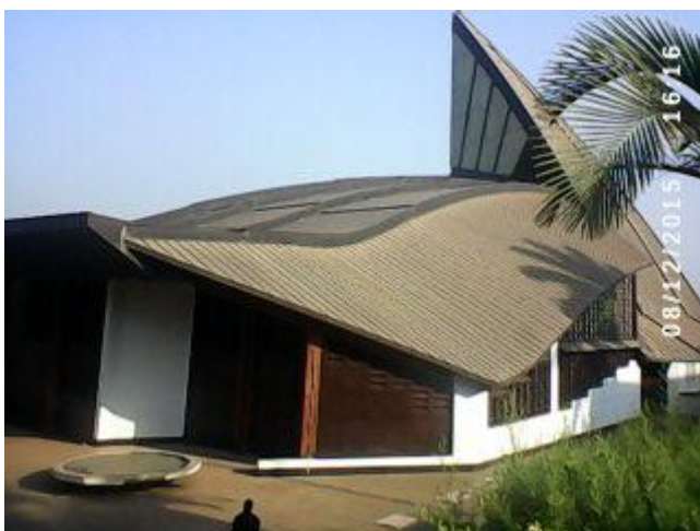
Photo 20 : La paroisse-Basilique MRA de Mvolyé : Un regard posé sur son architecture unique.
