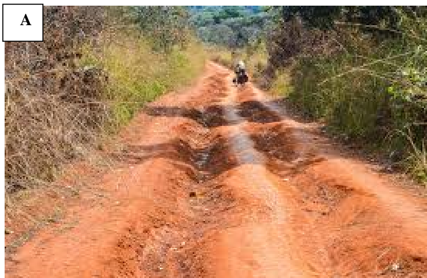
Photo 14 : La route allant à Nachtigal
