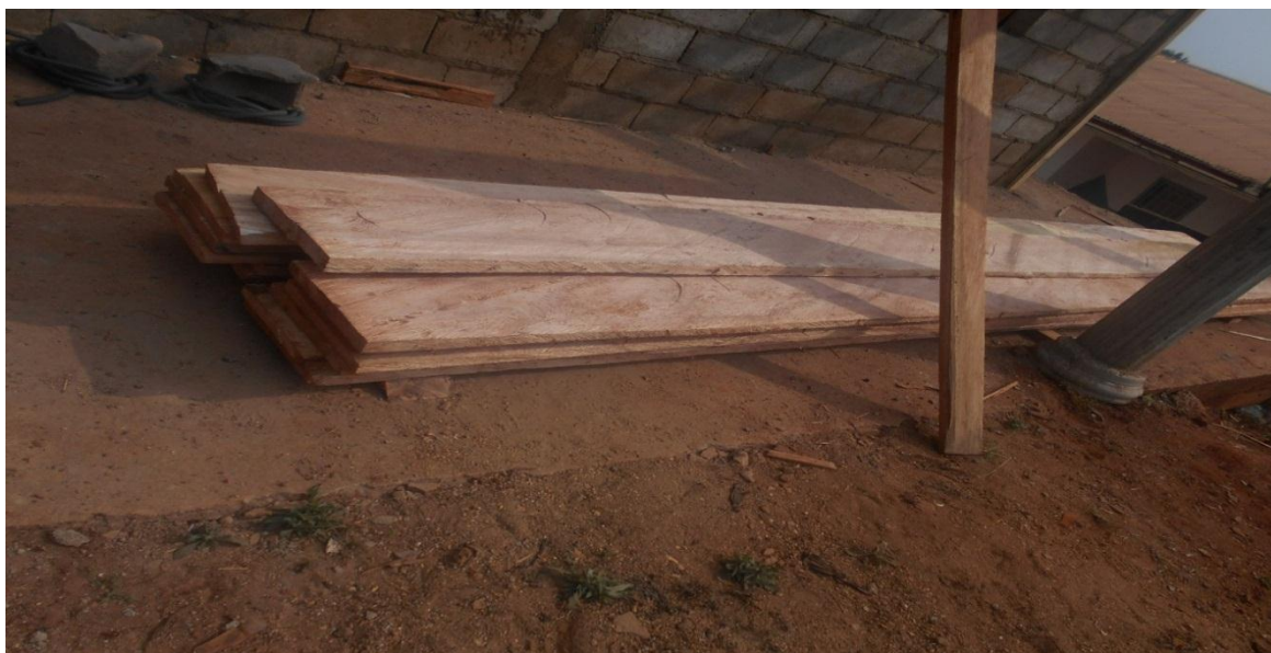
Photo 15: Planches utilisé pour le coffrage.
