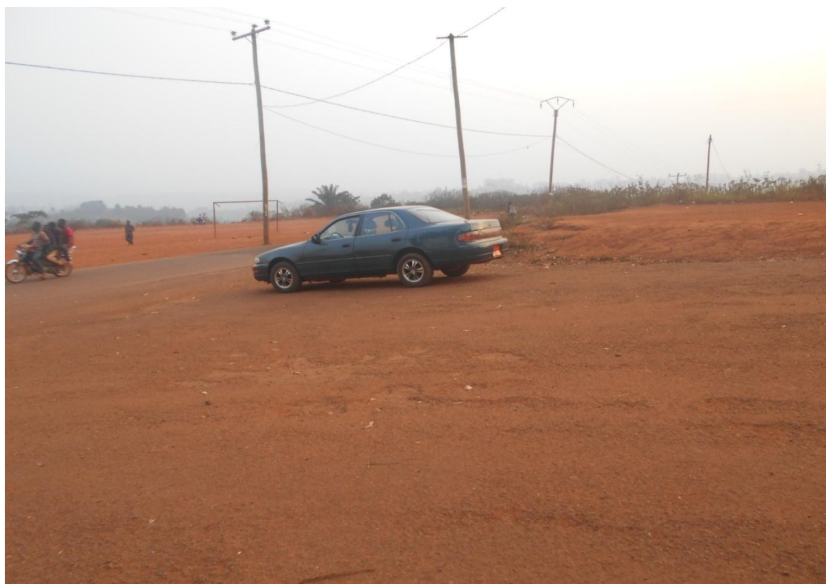
Photo 17: poteaux en Eucalyptus servant de relais de câbles électriques à Bangangté.
