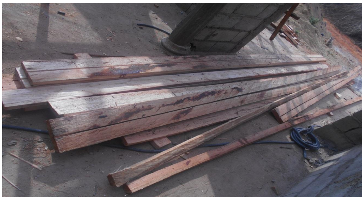
Photo 14: Lattes dans un chantier de construction pour la charpente.
