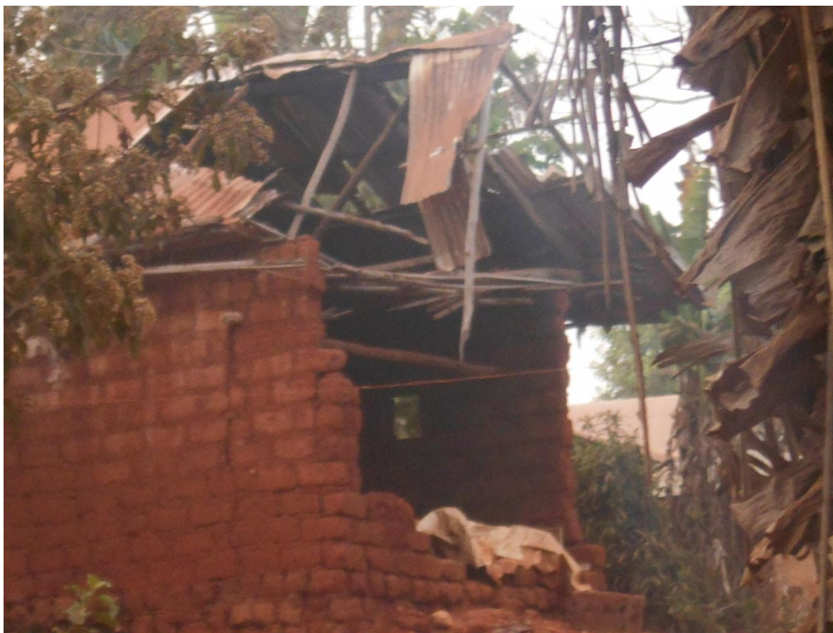
Photo 10: La toiture en bambou d'une maison à Bangangté.
