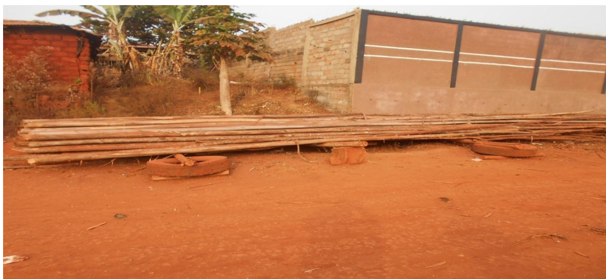
Photo 16: Les perches employées comme supports de la dalle.
