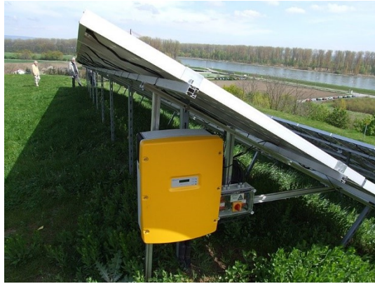
FIGURE 1.19 – Un onduleur pour une centrale solaire photovoltaïque [16]
