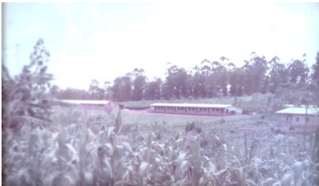
Photo 7 : Extension du site du CONODIC en 1976
