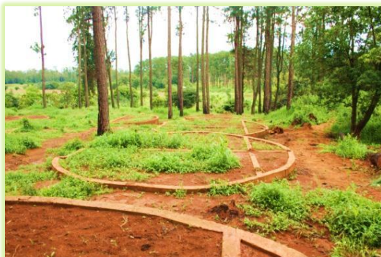
Photo d : les fondations des futurs bâtiments du bois de Mardock.
