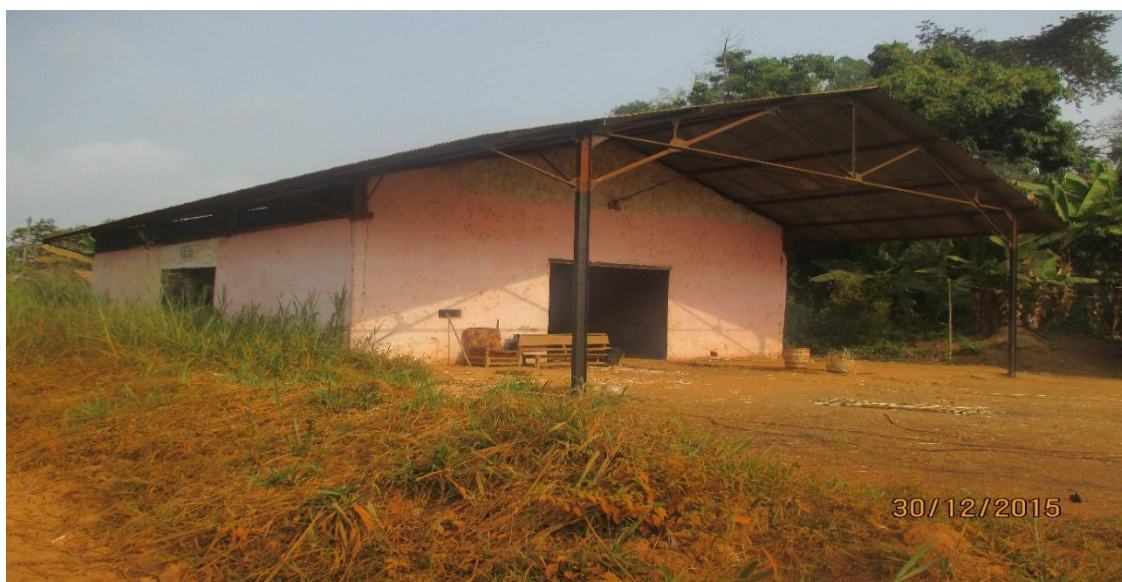
Photo 4 : Hangar d'Avebe- Esse (2015)
