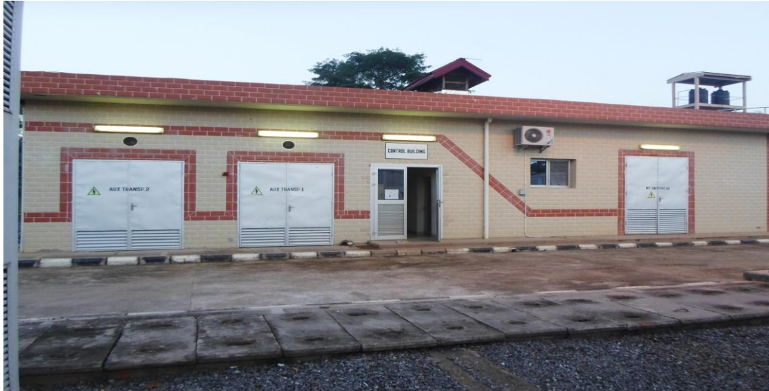
Figure 21: Salles de contrôle de la CTM
