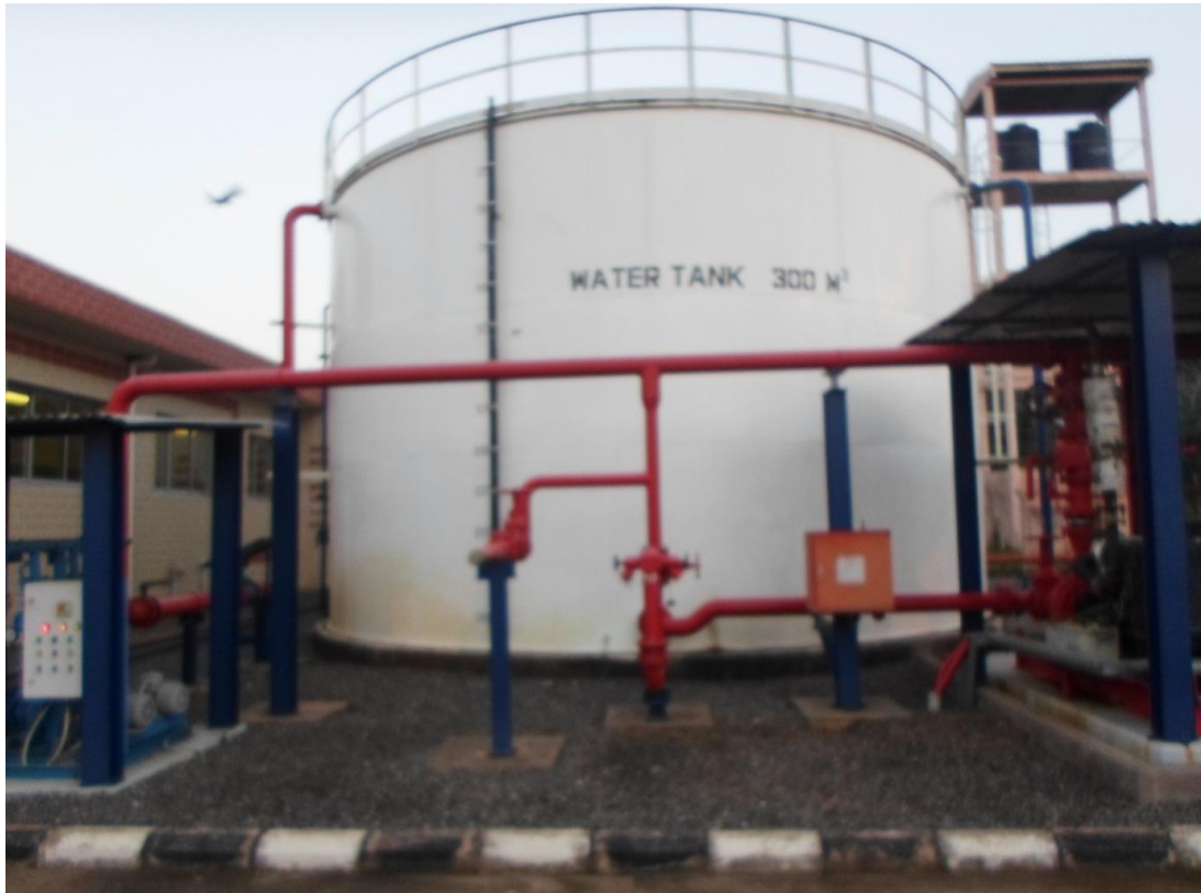
Figure 20: Tanks d'eau et de fioul de la CTM
