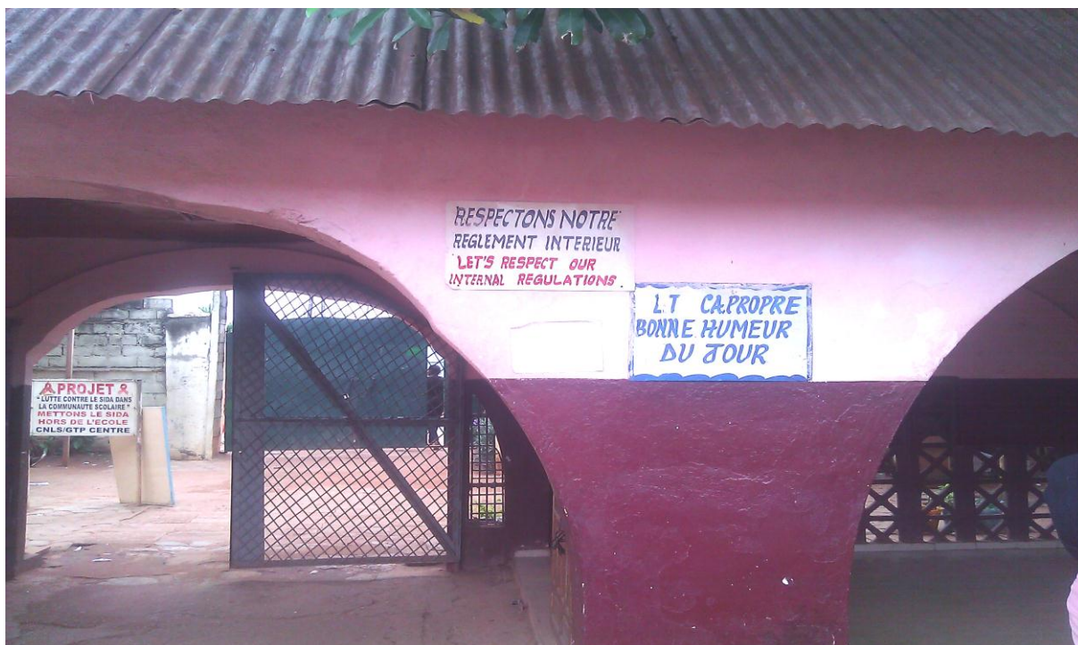
Photo 8 : plaque anti-vandalisme au Lycée Technique Charles Atangana
