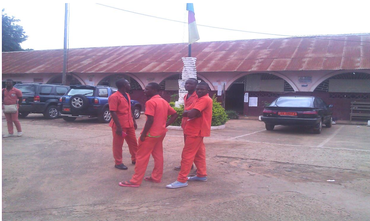
Photo 2 : vue interne des bâtiments et de la cour du Lycée Technique Charles Atangana
