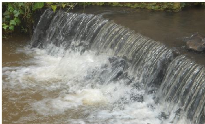
FIGURE 2.7 – Site de NYOM II
