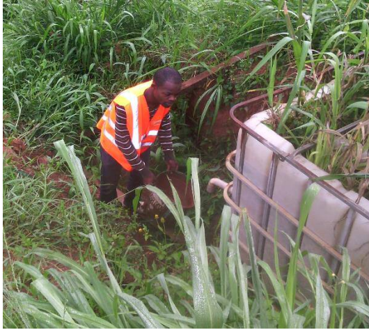
Figure 29 : photo sortie du filtre 2.
