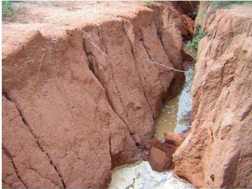
Photo 33 : Ravinement en amont du bassin du kori Tyala : profondeur moyenne 4 à 6 m.
