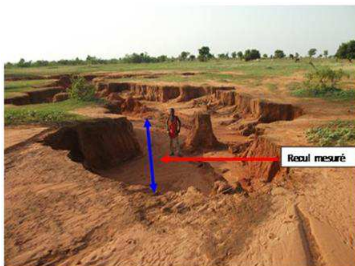
Photo 2 : Recul de tête de la ravine engendré par la pluie du 5 juillet 2011
