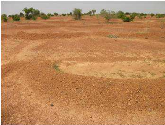
Photos 10 et 11 : Ouvrages antiérosifs : à gauche demi-lunes et à droite banquettes sur le plateau de Dyabou
