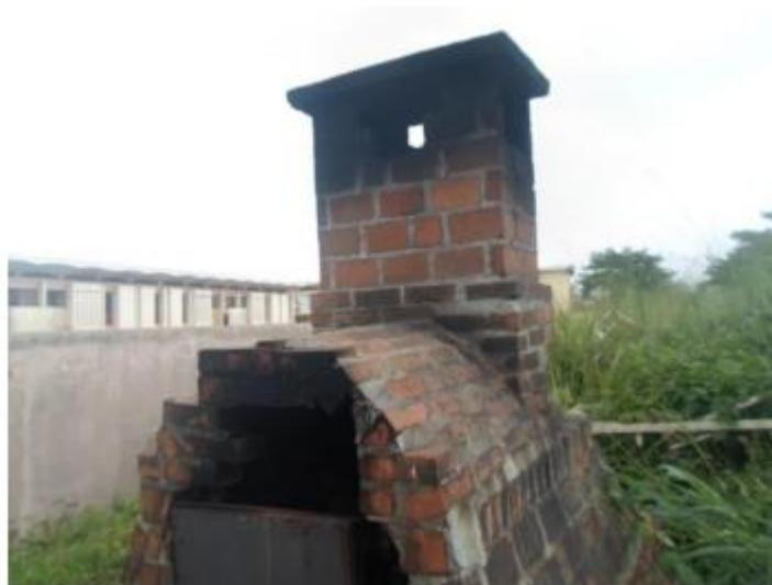
Figure 3- Hauteur de la cheminée inférieure à 3m[13]
