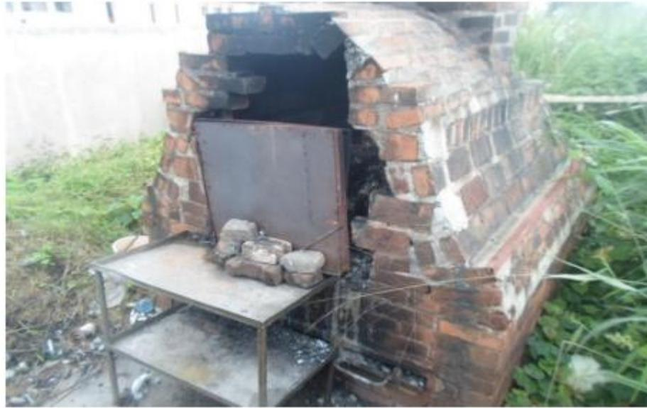
Figure 2- Briques de terre, ciment non adapté ce qui engendre les cassures[13]
