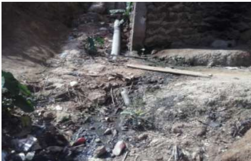
Photo 1 : Arrivée du réseau d'égout des EUD de Camp-Sic Mendong sur le site de déversement
