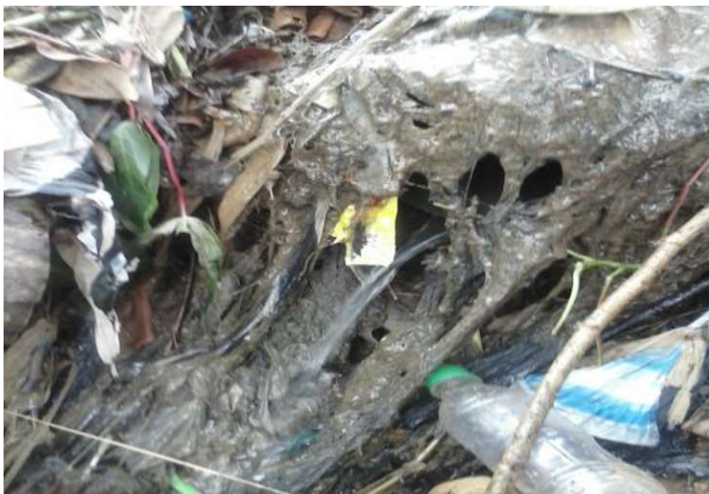
Photo 2 : Déversement des EUD de Camp-Sic Mendong du réseau d'égout pour l'exutoire
