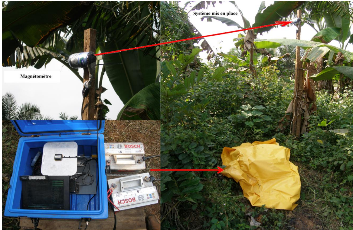
Figure 2.4: Magnétomètre de la station de base installé sur le site qui communique en simultané en envoyant les signaux pour une bonne acquisition des données aéromagnétiques (Latrous et al., 2013).
