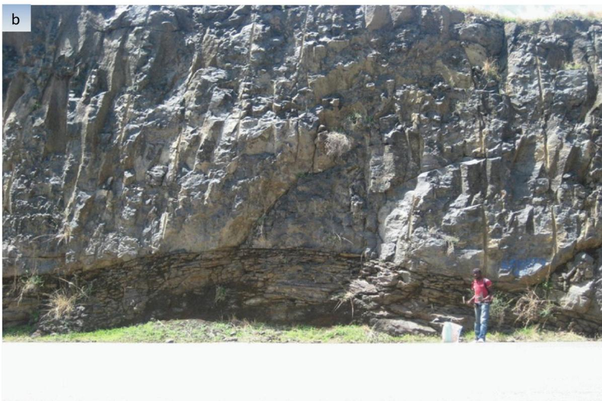
**Figure 16.** (a) Tranchées routières du nouvel axe routier Ngaoundéré – Touboro montrant des affleurements de coulées basaltiques. (b) Deux (02) types morphologiques de coulées sont distingués sur le talus sud ; les coulées grossièrement prismées au sommet reposent sur les coulées en dalles à la base de la tranchée (Tiabou, 2009).
