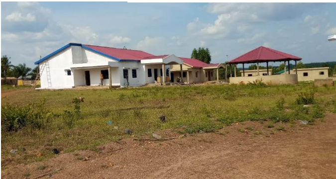
Photo 2 : Nouvel hôpital en construction par AMEA POWER
