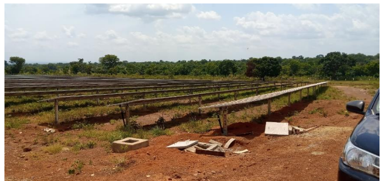
Photo 6 : Derniers travaux de finition en cours
