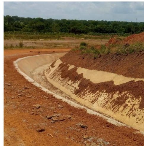
Photo 3 : Caniveau construit pour le drainage des eaux du site
