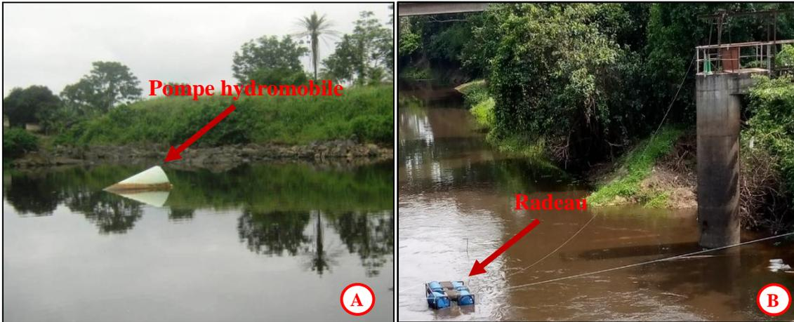
**Figure 9** : Prises d'eau (A : Pompe hydromobile à Aboisso et B : Radeau à Issia).
