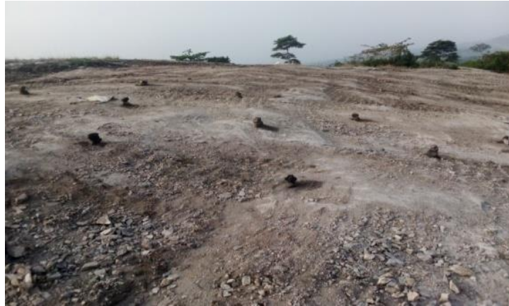
Figure 2 : Implantation des trous de mines sur la carrière de granite
