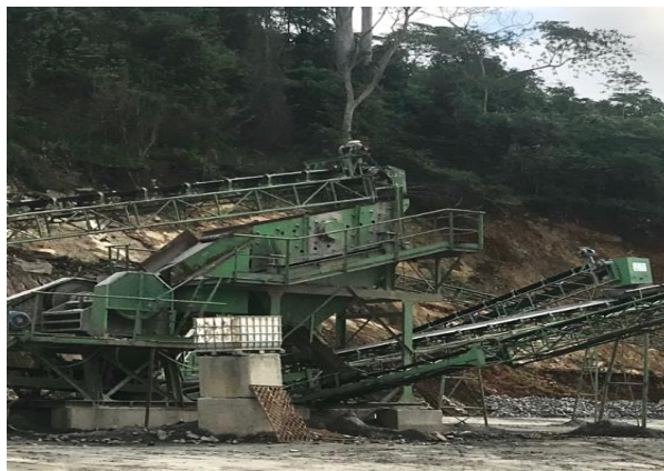
Figure 7 : Marteau concasseur de granite utilisé par l'entreprise ECBI
