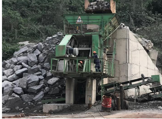
Figure 6 : Dispositif du concasseur primaire de granite utilisé par l'entreprise ECBI
