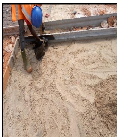
Figure 12 : Enduction d'un panneau avec l'huile de vidange
