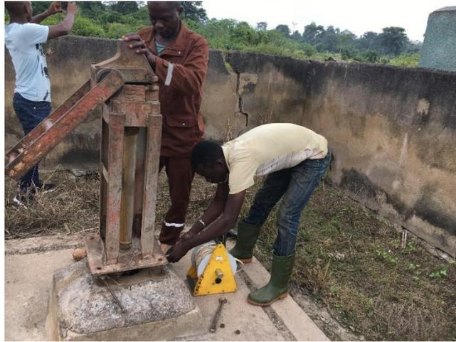
Figure 25 : Prise de niveau d'eau dans un forage dont la pompe est non fonctionnel à Pélezi
