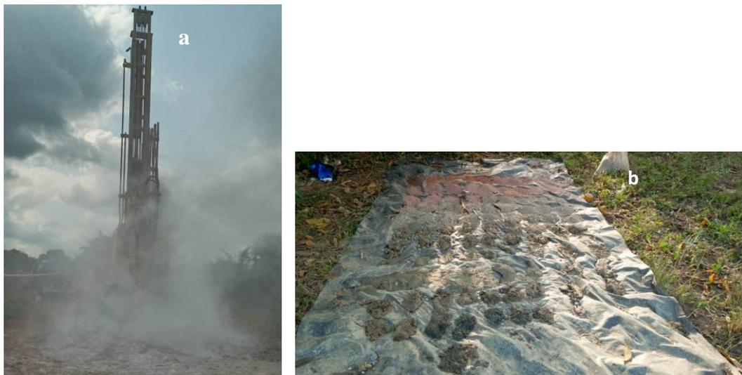
**Figure 31** : Réalisation d'un forage à Daloa. a) Fonçage dans la roche saine et b) dépôts des cuttings à chaque mètre de l'avancement du forage
