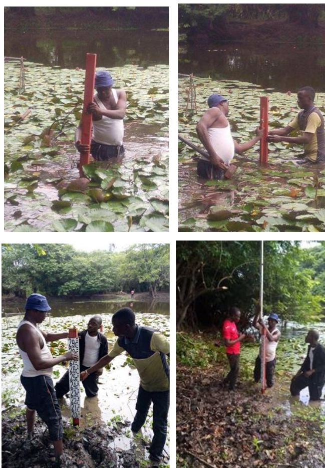
Figure 24 : Installation de la station hydrométrique de Sikaboutou-Andjoukro en amont de la retenue
