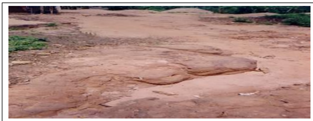
Photo 17 : Phénomène d'érosion sur le talus à Hounviguè / Affamè Cliché DOSSOU, mai. 2005
